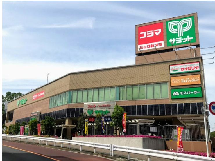
図 8 食料品スーパーの取組事例 太陽光発電パネルの壁面設置 20
