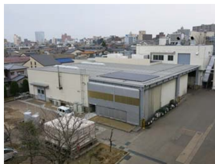
石川県に導入した植物工場外観 (屋根部分に太陽電池を設置)
