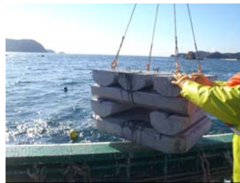
兵庫県防勢島、魚礁ブロック設置風景
