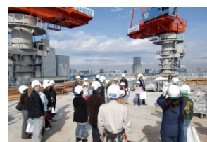
<新本社現場見学会の様子>
