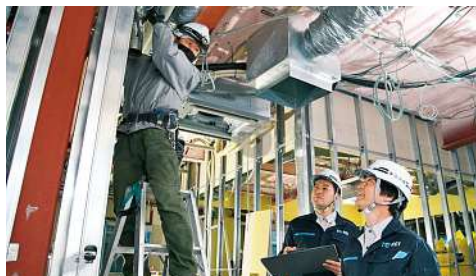
現場(施工・サービス)
