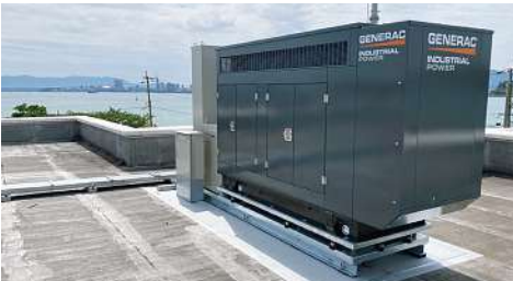
停電時はもちろん、平常時も電力ピークカットに貢献するLPガス発電機
