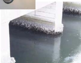
発電所の冷却水取水路に付着したムラサキガイなどの貝類
