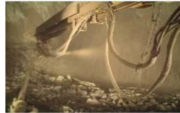
トンネル工事で使用される吹付けコンクリートの使用材料の一部をフライアッシュに置き換えることで、吹付け時の跳ね返り飛散低減による使用材料の節約や、粉じん量の低減による作業環境の改善が図れる
