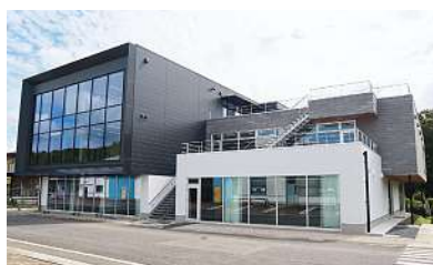
新屋竣工 (2024年10月)
