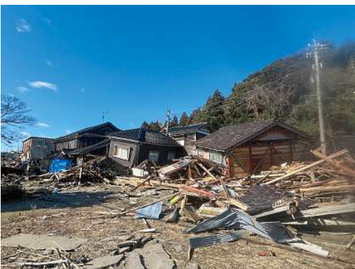
珠洲市の被災の様子
