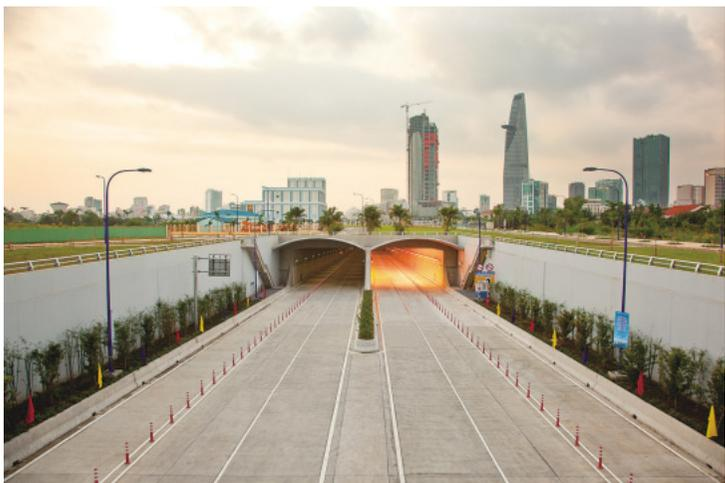
ベトナム・サイゴン川の底を通るトンネルと、その両側の開削トンネルを含む高速道路
