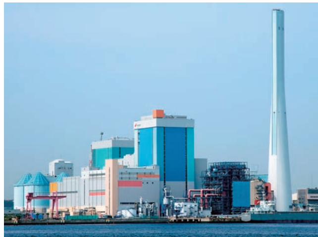
最新鋭の磯子石炭火力発電所全景(横浜市)
