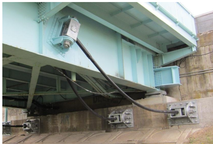
ピン定着落橋防止装置の設置事例 C
